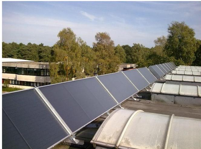
Abbildung 13: Luftkollektor Sporthalle Remels (Quelle IB-Emden)
