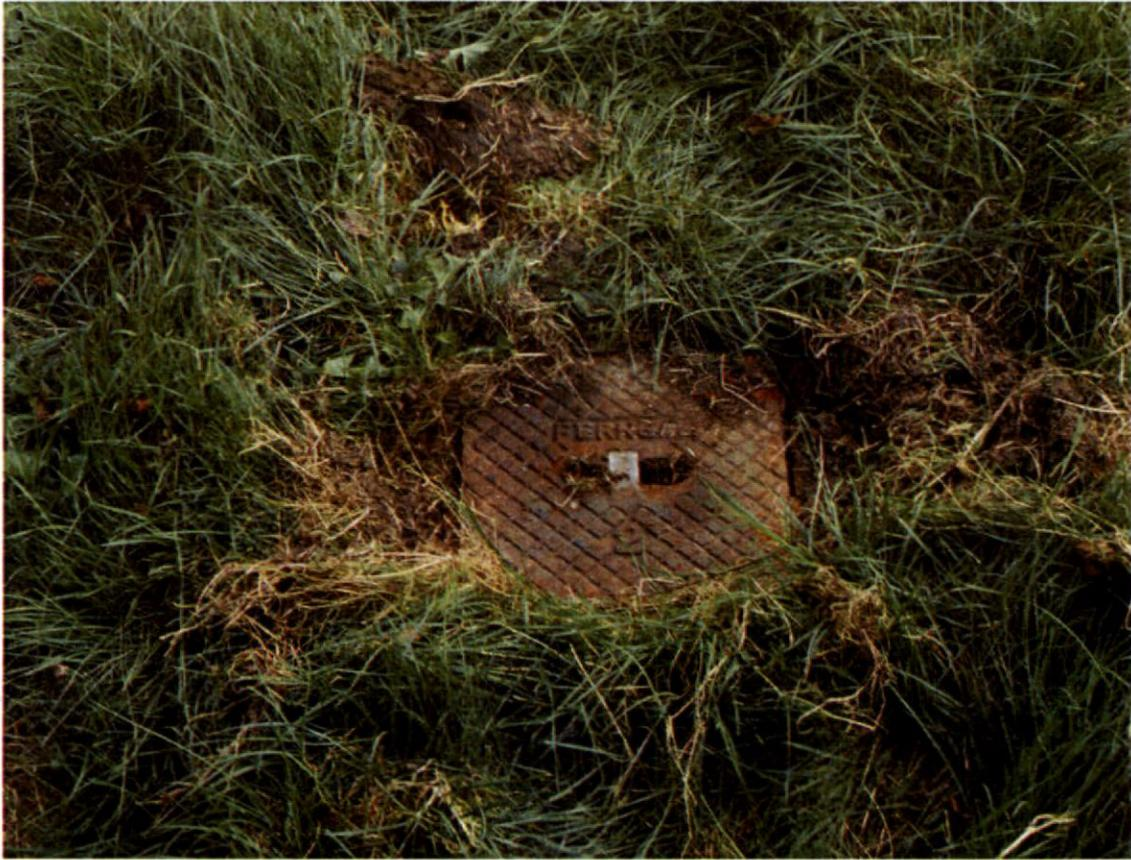
**Bild 12: Unterflurabschluss der Messstelle B13 (B12 identisch ausgebaut)**
