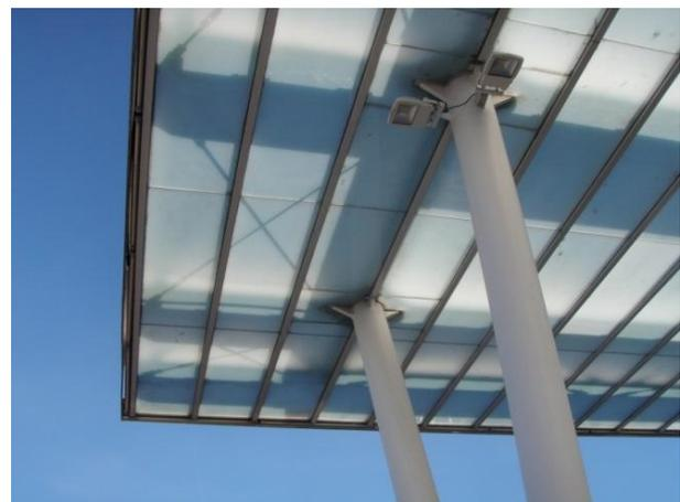
Abb.: Lofer, Detail der transluzenten Dachkonstruktion
