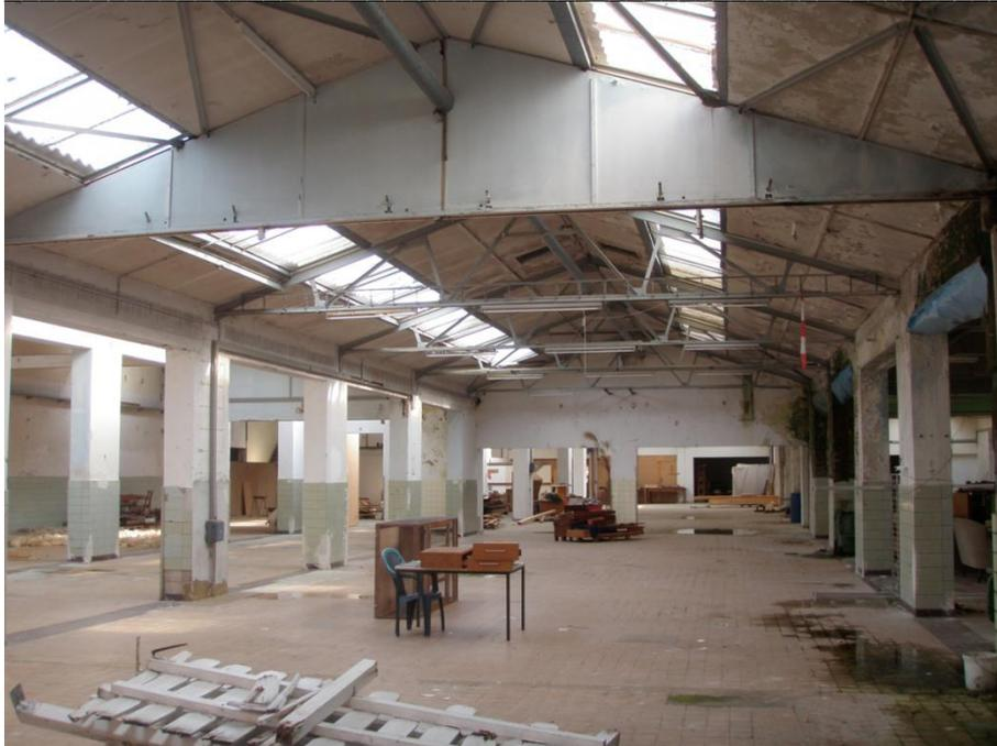
Halle südlich angrenzend an Popken: Funktionales Stützenraster, gutes Tageslicht, interessante Stahl-Fachwerkkonstruktion und großes Flächenangebot machen die alten Packhalle trotz einiger Dach- und Feuchtigkeitsschäden geeignet für eine wie auch immer geartete Um- oder Zwischennutzung.
