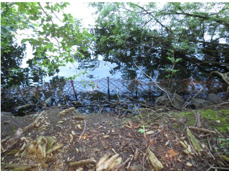
Bild 9: Wasserbausteine mit Maschendraht
