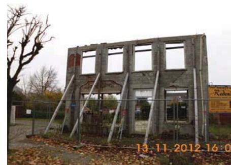
Bild 2-5: Am Markt 67, restliche Fassade 2013 abgebrochen
