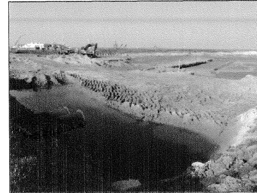
Abb. 2: Spülfelder mit Baggerarbeiten
