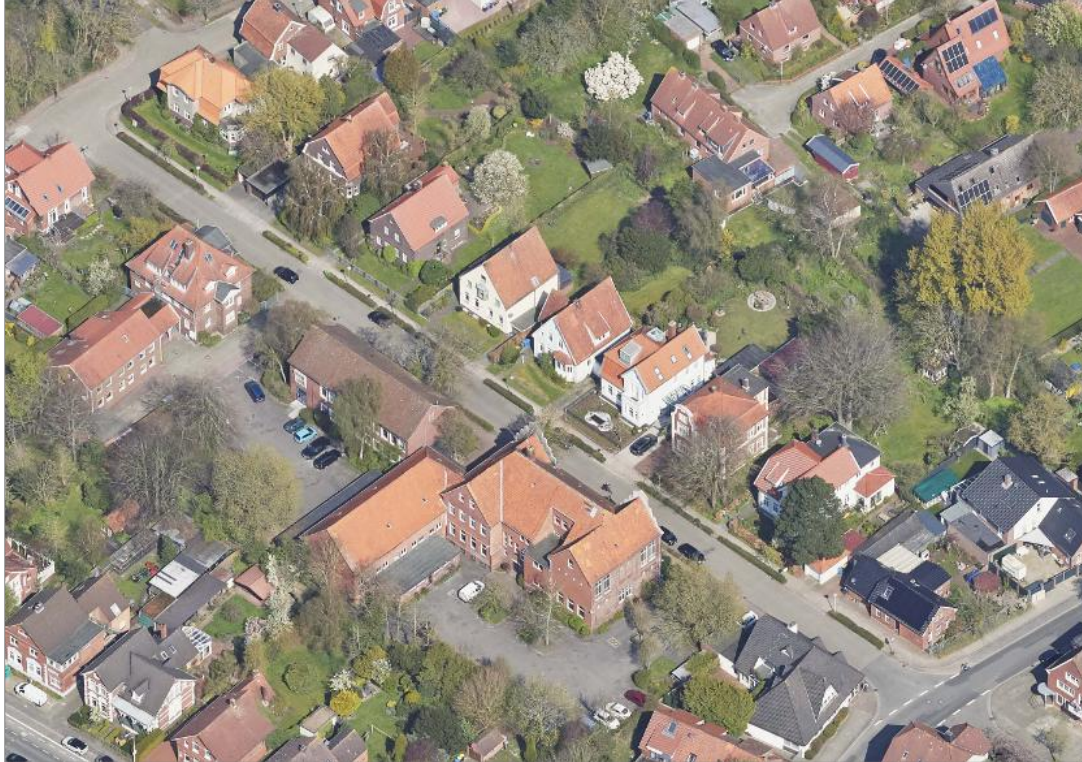
Luftbild Teilbereich Erhaltungssatzung „Gartenstraße“
