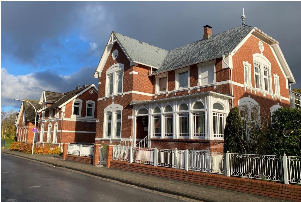
Straßenansichten Teilbereich Erhaltungssatzung „Linteler Straße“ (D)
