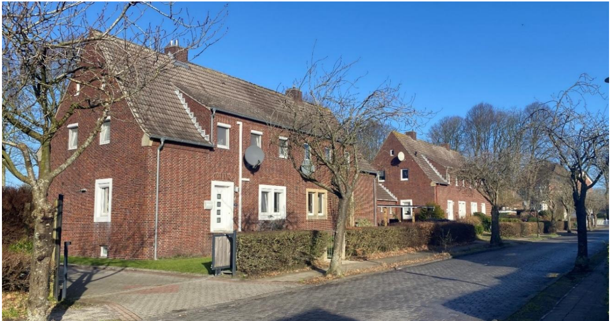
Straßenansicht Teilbereich Erhaltungssatzung „Am Sportplatz 1-13“ - (F)
