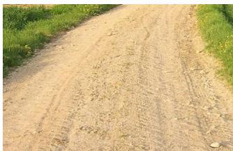
Bsp. wassergebundene Deckschicht / Schotterrasen
