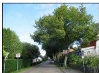
Dieser Raumtyp umfasst einen einseitigen Gehweg und einen einseitigen Grünstreifen mit Bäumen, welcher nur von den Grundstückszufahrten unterbrochen wird. Diese Art der Gestaltung ist besonders geeignet für den Umbau einer bestehenden Straße, bei welchem einseitig ein Gehweg aufgehoben wird und ein Grünstreifen mit Bäumen an dieser Stelle entsteht.
